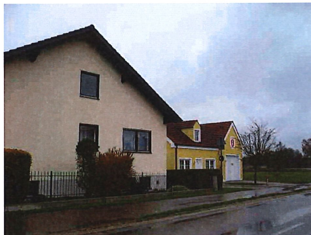
Bild 5 Wohnbebauung an der Abzweigung südlich
